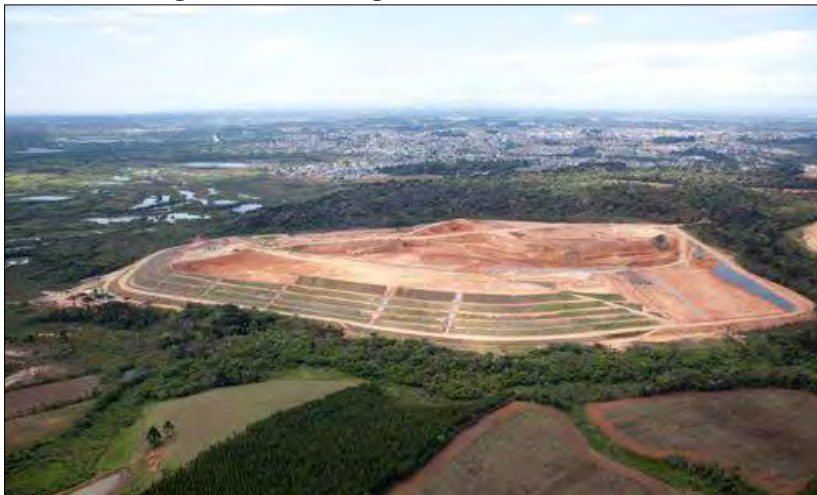
Figura 298: Vista geral do aterro sanitário.
