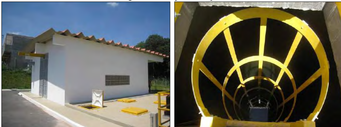
Figura 221: Poço de sucção.
