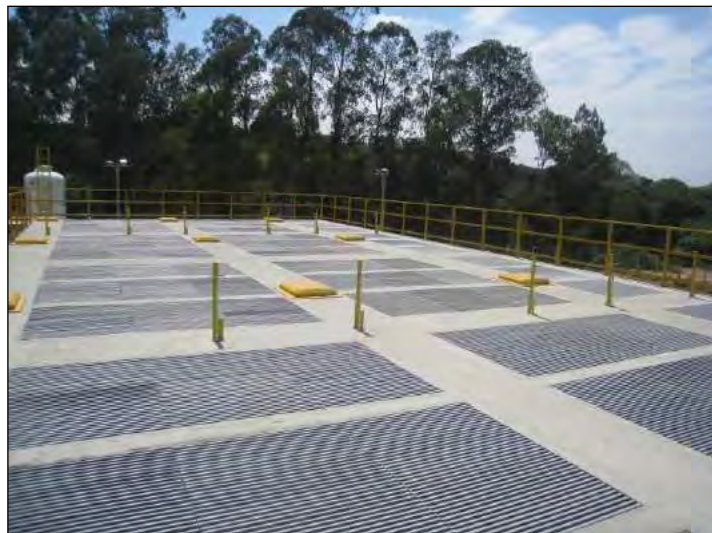
Figura 233: Detalhes do RALF da ETE Passaúna.
