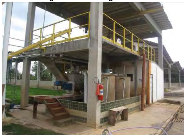
Figura 262: Centrífuga do lodo.
