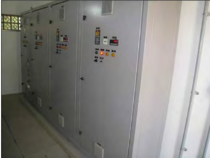
Figura 226: Inversor de frequência da EEE Passaúna.
