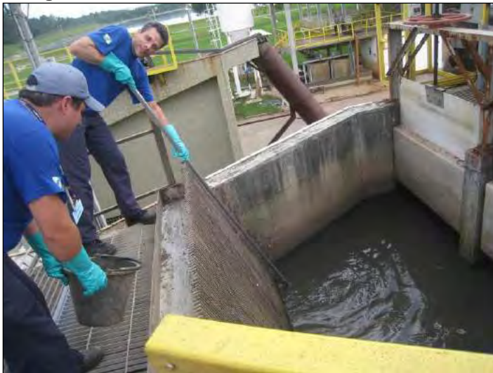
Figura 252: Gradeamento manual de sólidos finos.
