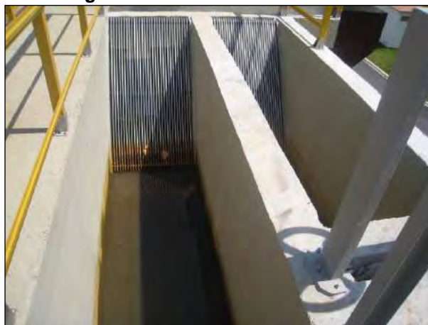
Figura 229: Gradeamento manual.
