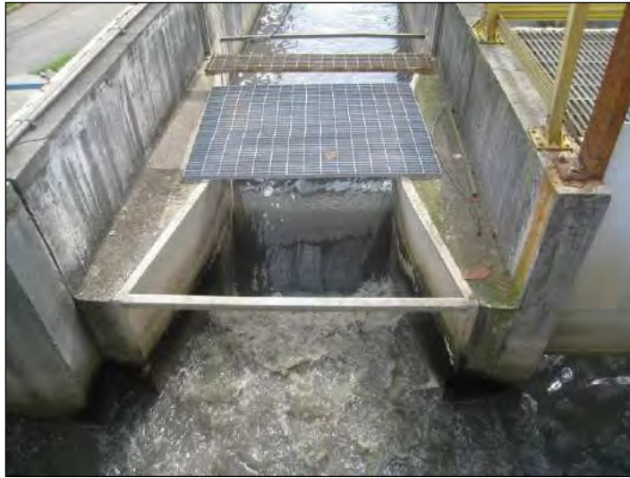
Figura 255: Calha Parshall.
