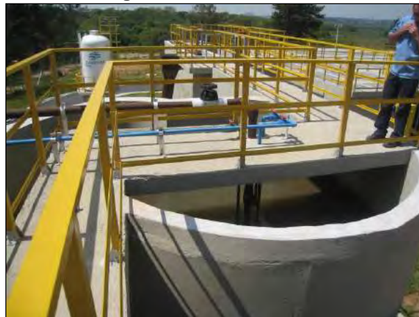
Figura 230: Desarenador.
