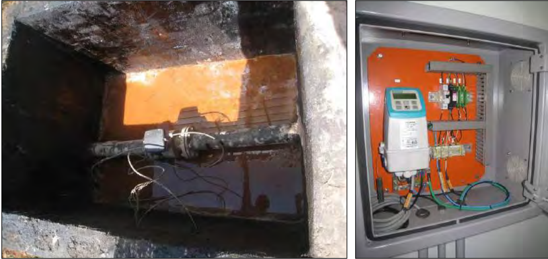
Figura 248: Macromedidor Eletromagnético.
