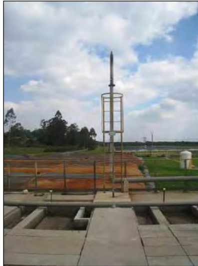
Figura 257: Queimador de gases.
