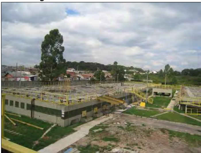
Figura 249: Reforma na ETE CIC Xisto.
