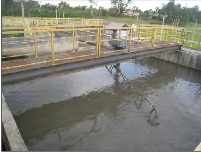
Figura 253: Desarenador.
