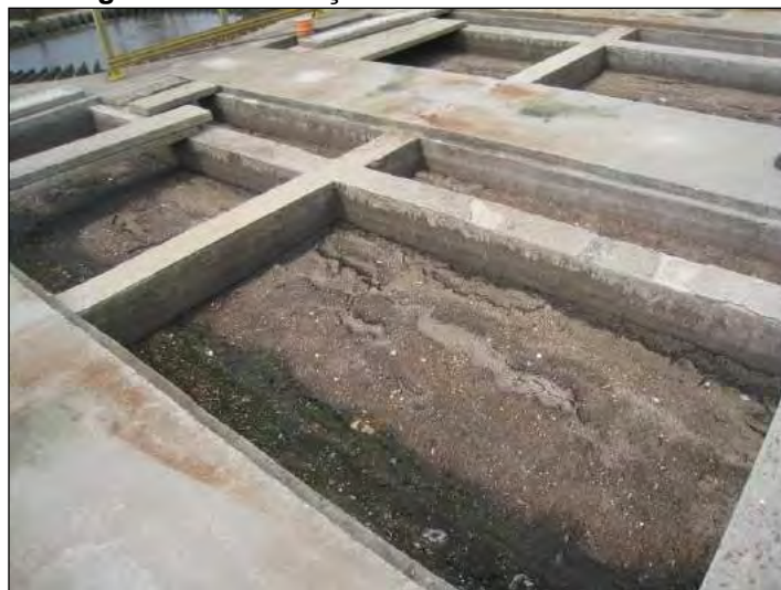
Figura 258: Formação de espuma nos reatores.
