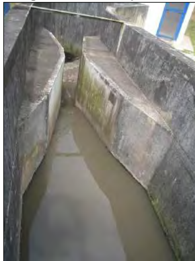
Figura 215: Calha parshall.
