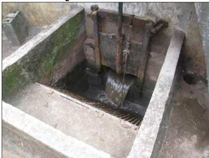
Figura 194: Gradeamento.
