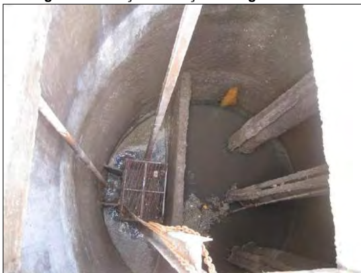
Figura 197: Poço de sucção com gradeamento.
