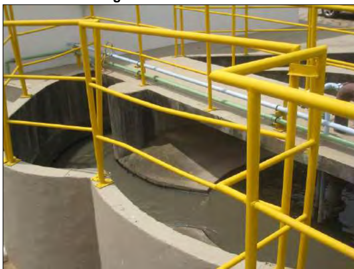
Figura 201: Desarenador.
