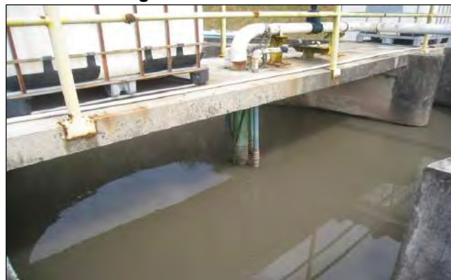
Figura 214: Desarenador.
