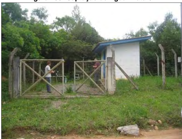
Figura 155: Captação de Água Bruta 01.
