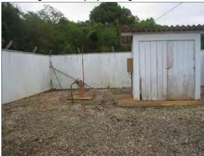
Figura 167: Captação de Água Bruta 01.
