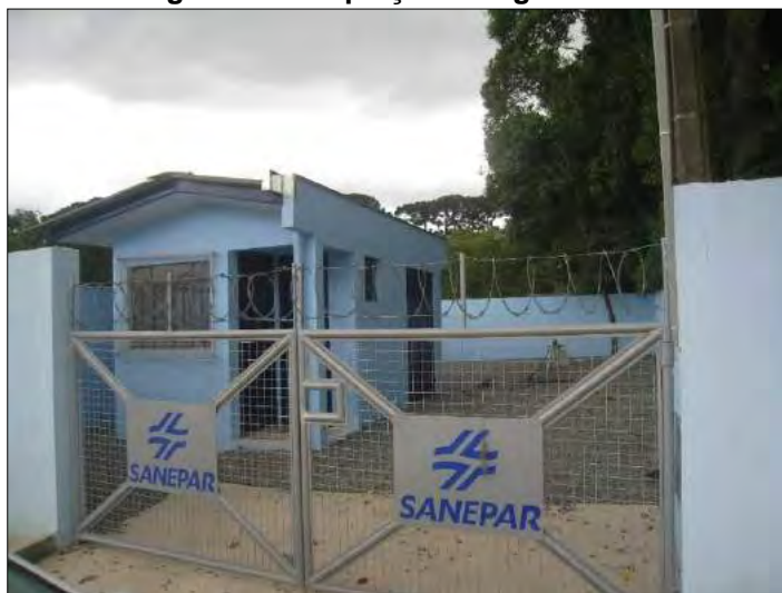
Figura 141: Captação de Água Bruta.
