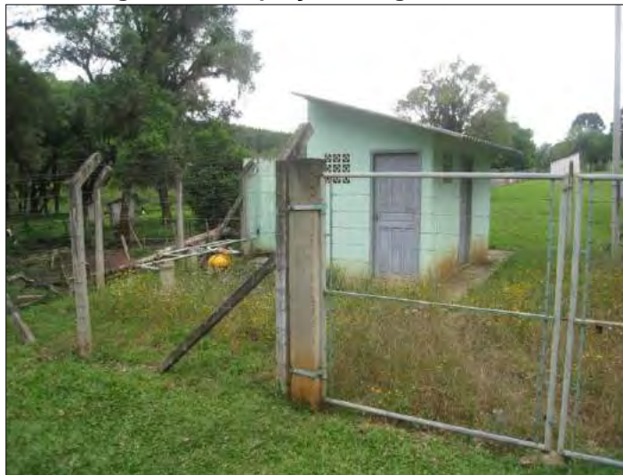
Figura 170: Captação de Água Bruta 01.
