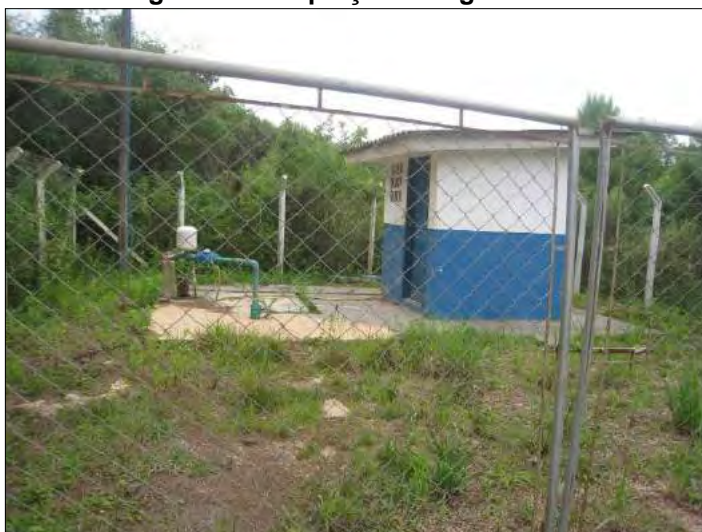
Figura 162: Captação de Água Bruta.
