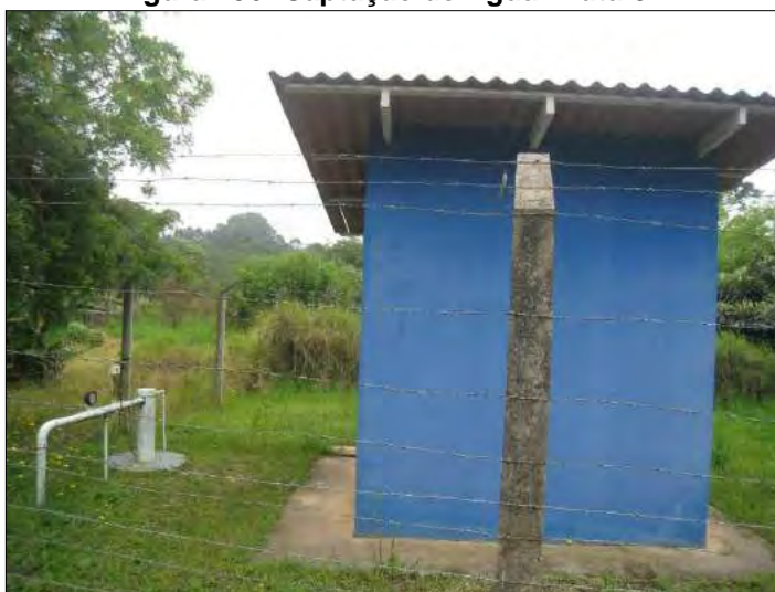
Figura 156: Captação de Água Bruta 02.
