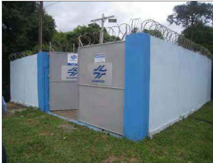
Figura 146: Captação de Água Bruta.
