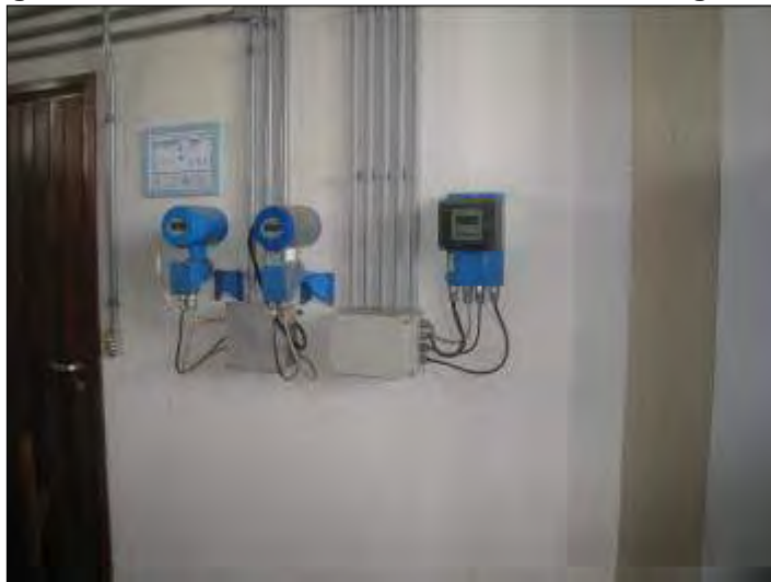
Figura 111: Secundário do macromedidor eletromagnético.
