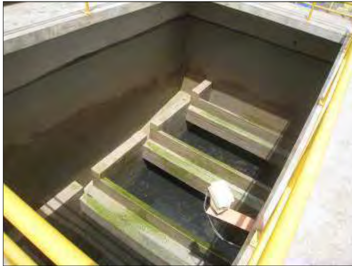
Figura 100: Filtro Descendente.
