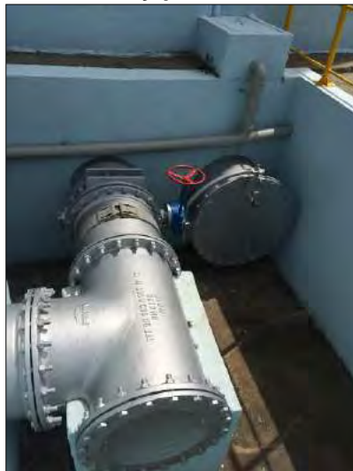
Figura 126: Sistema de by-pass do reservatório Costeira.
