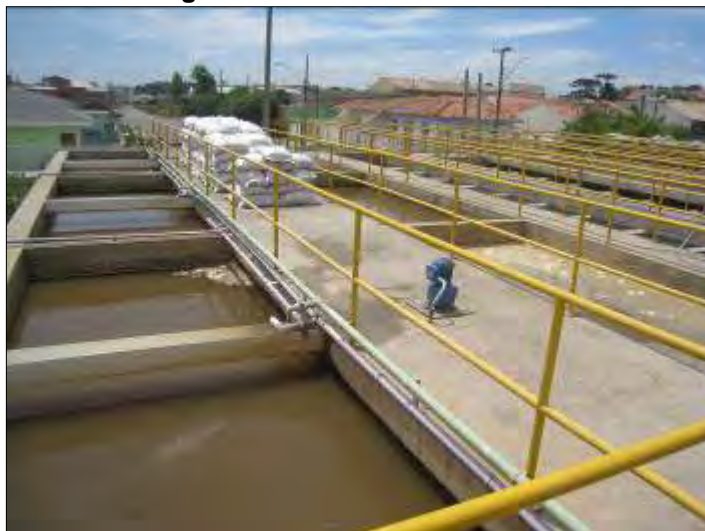
Figura 98: Floculador Mecânico.
