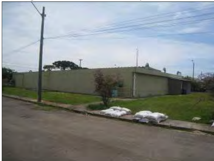
Figura 101: Reservatório - tanque de contato.
