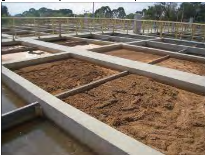
Figura 77: Formação de sólidos na superfície do floculador.
