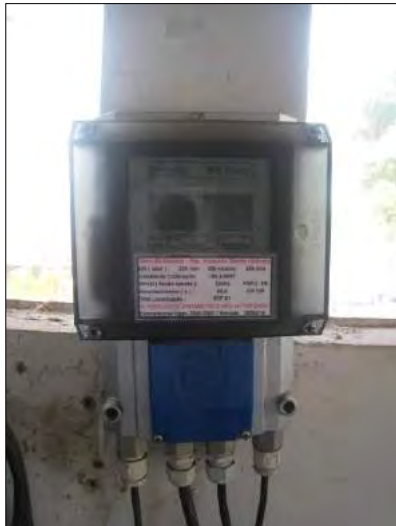
Figura 120: Macromedidor Eletromagnético.
