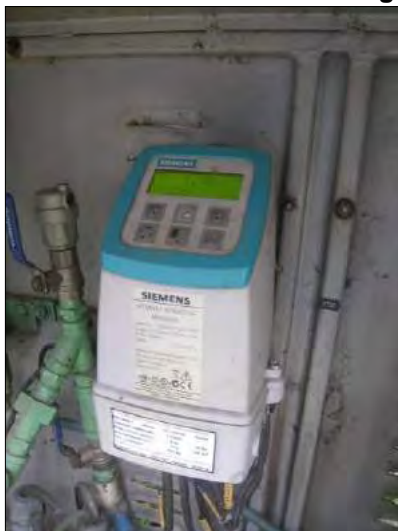
Figura 134: Macromedidor eletromagnético.
