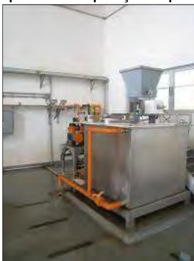
Figura 85: Equipamento de aplicação do polímero aniônico.
