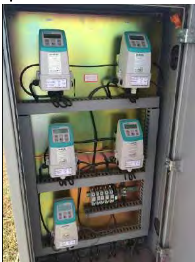
Figura 131: Receptores dos macromedidores eletromagnéticos.
