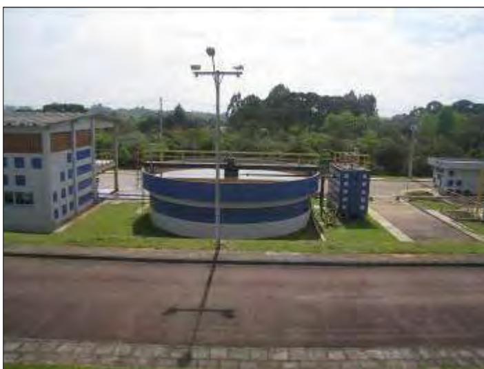
Figura 83: Tanque de armazenamento da água de limpeza.
