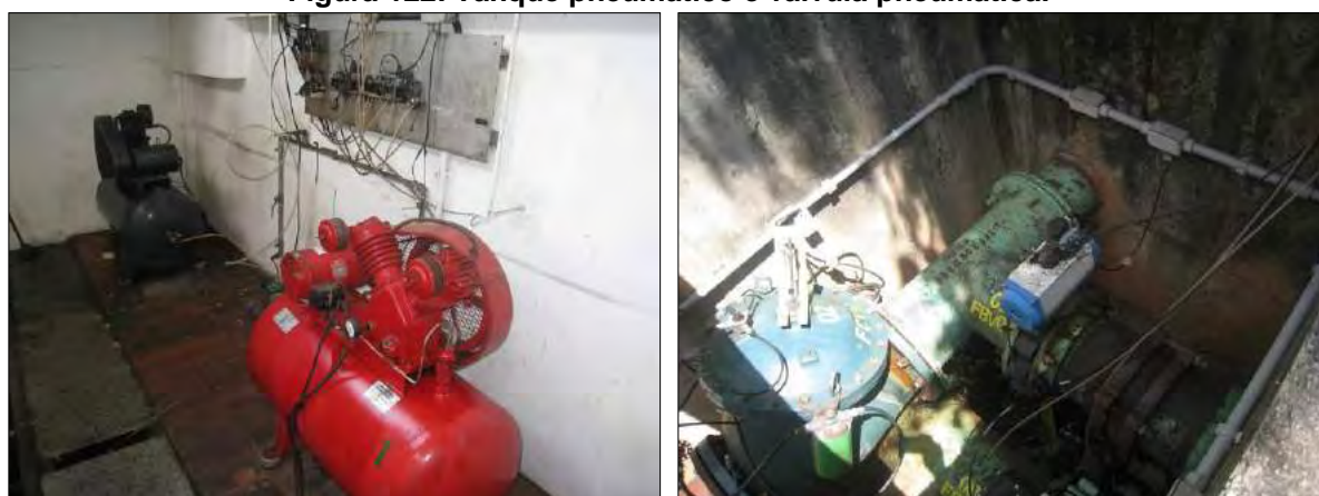
Figura 122: Tanque pneumático e válvula pneumática.
