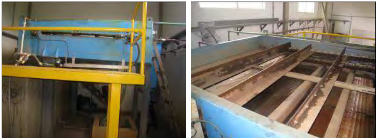
Figura 105: Cama de desague do lodo.
