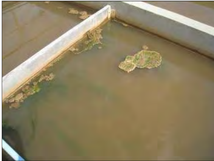
Figura 78: Formação de algas na superfície do floculador.
