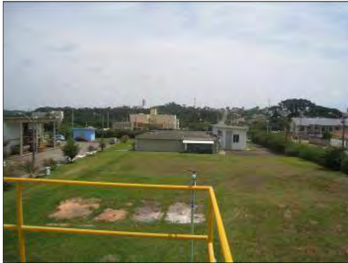
Figura 107: Reservatórios da ETA Industrial.
