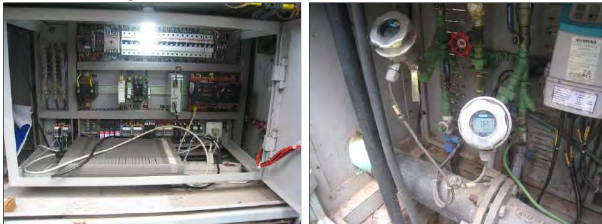
Figura 133: Sistema de acionamento do booster Bela Vista.
