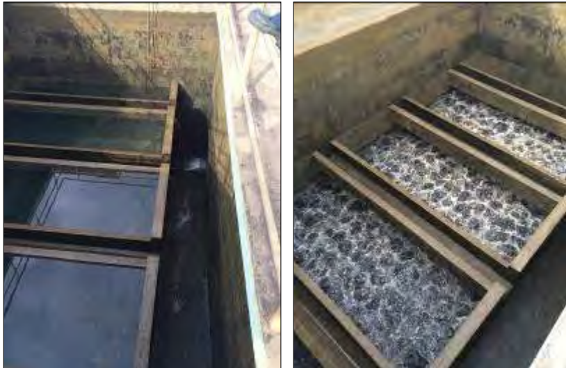
Figura 48: Aeração do leito filtrante.
