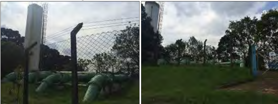
Figura 37: Vista das 2 torres RHO de 50 m 3 .
