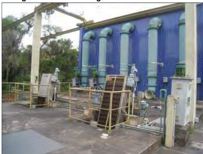
Figura 67: Sistema de gradeamento mecanizado.
