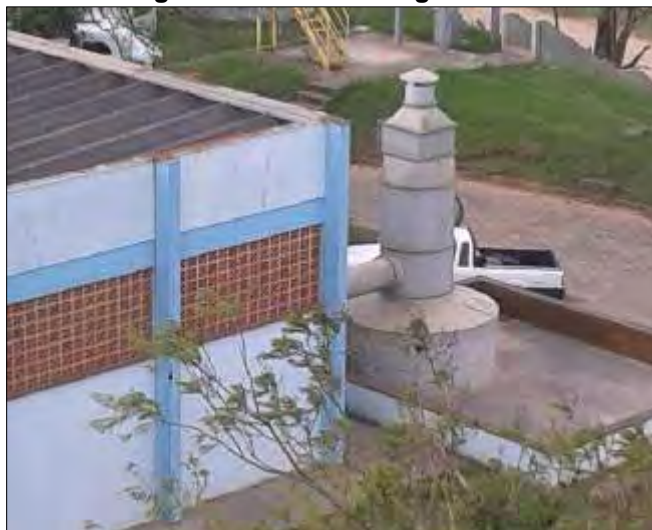
Figura 52: Lavador de gás cloro.
