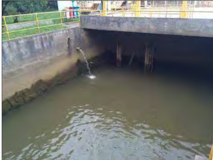
Figura 53: Tanque de armazenamento da água de limpeza dos filtros.
