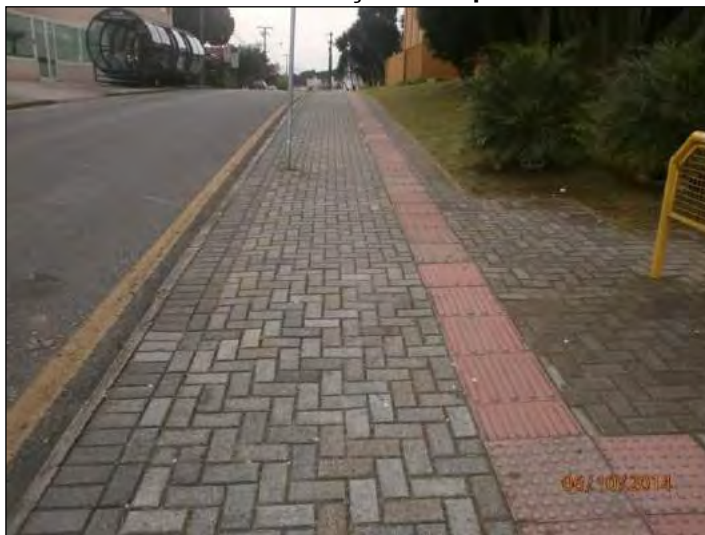
Figura 391: Emprego de calçada tipo paver em diversos pontos do município, exemplo no Centro – Paço Municipal.
