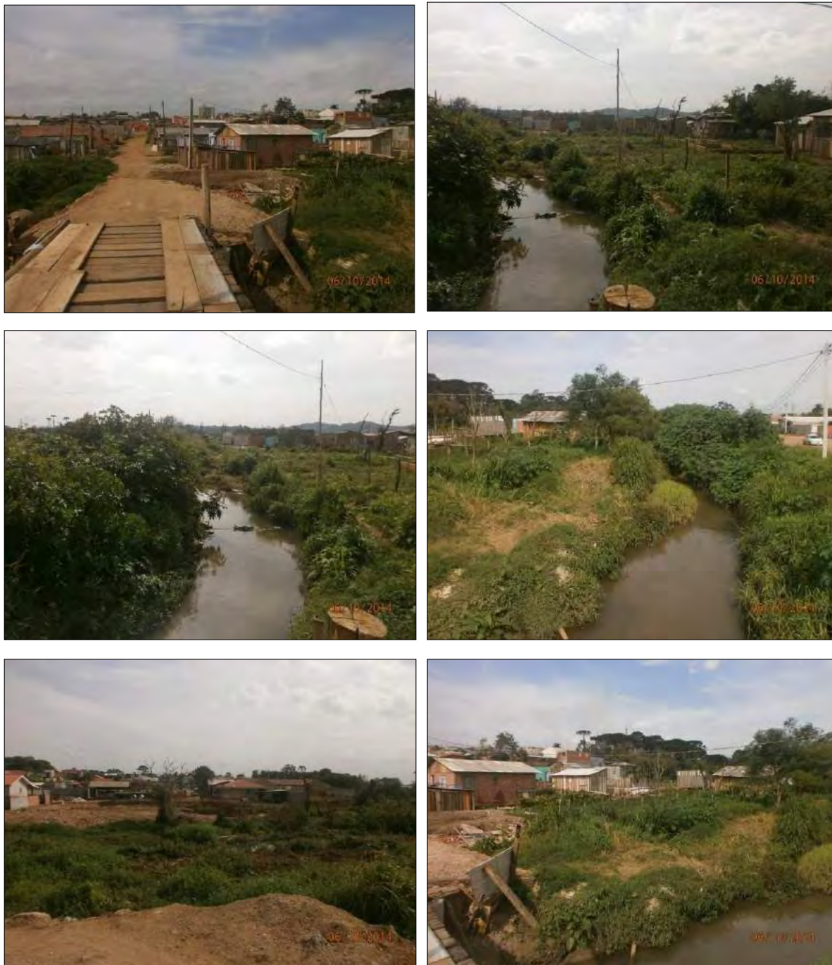
Figura 396: Loteamento Arvoredo, Bairro Capela Velha – ocupação irregular de fundo de vale urbano de afluente do rio Passaúna. Residências indevidas no fundo de vale.
