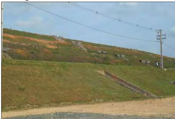
Figura 303: Célula encerrada e sistema de drenagem pluvial e de gases (outubro/2014).
