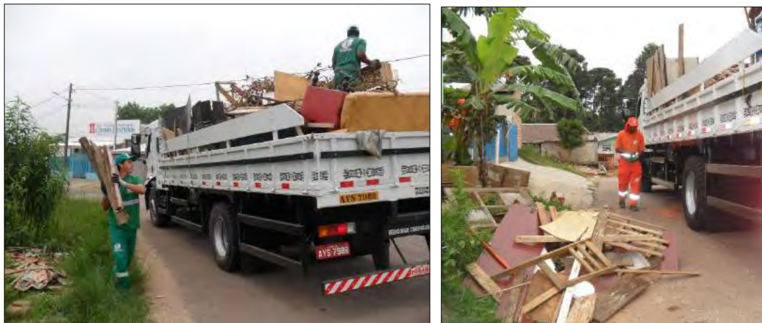
Figura 331: Execução dos serviços auxiliares de limpeza padronizada.
