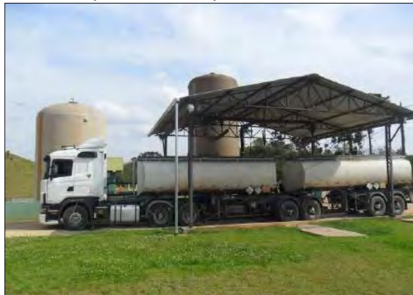
Figura 302: Armazenamento temporário do chorume e caminhão coletor para transporte e destinação à ETE, respectivamente (outubro/2014).
