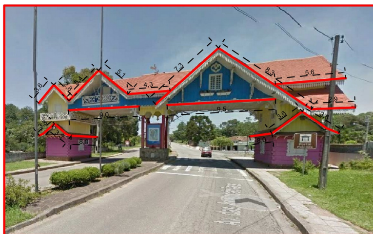
FIGURAS 9: DETALHES DOS LOCAIS DE INSTALAÇÃO DO PORTAL POLÔNICO
