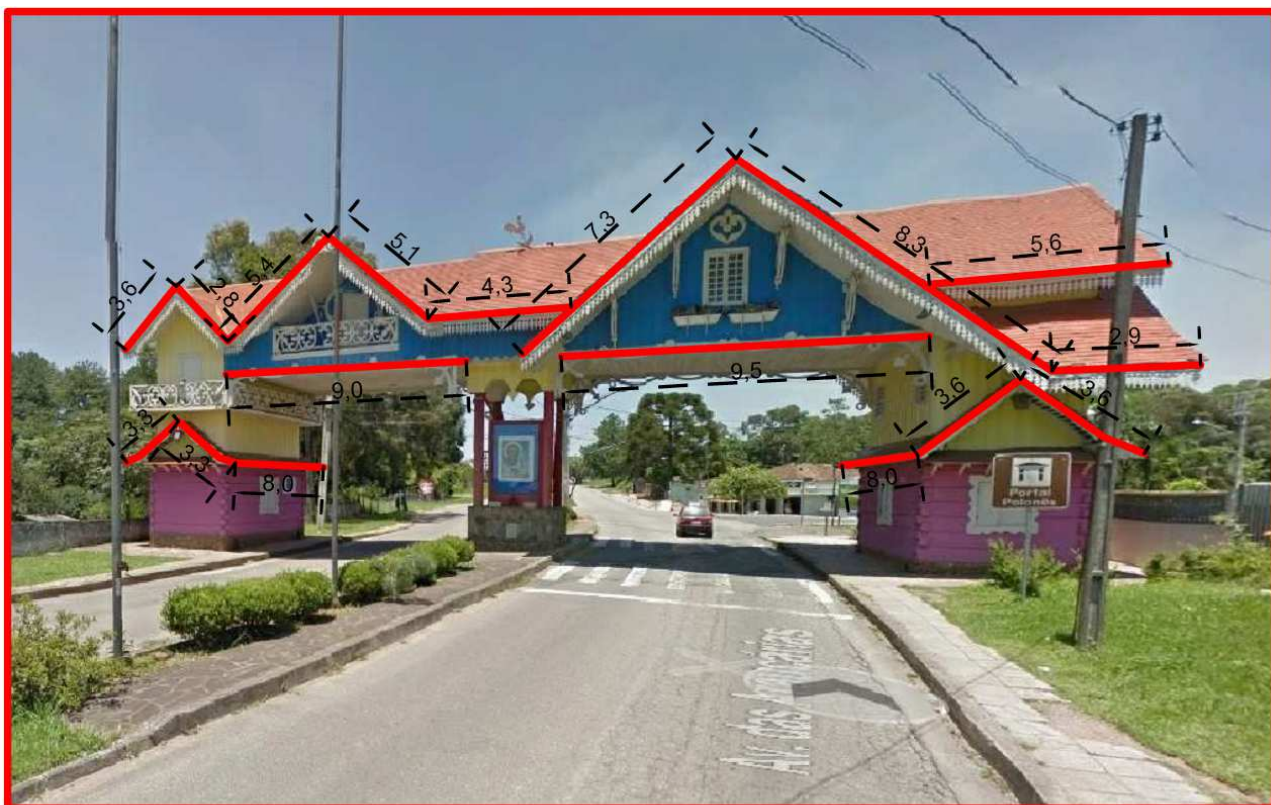
VISTA SENTIDO BAIRRO CENTRO
